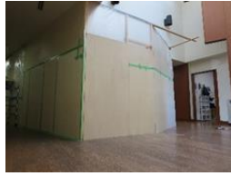
▲トイレ改修中の2階フロア
